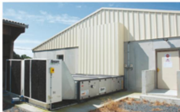
*Le CIA porcin de Pont-Hébert est un atelier assaini, conduit sous air filtré, filtration et cooling en amont.*
