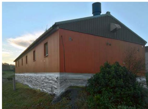
Figure 6. Préfosse isolée avec de la mousse projetée (source Porc.Spective).
